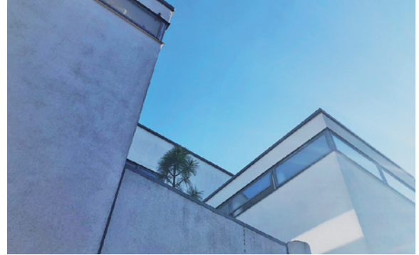
Die Reihenhäuser von J. J. P. Oud in der Stuttgarter Weissenhofsiedlung
